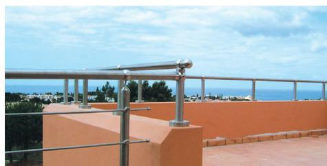
Per i prodotti in acciaio inossidabile installati vicino al mare, devono essere resistenti all'acqua di mare. Vengono utilizzati prodotti di qualità V4A ( **X** ) componenti della nostra gamma).
