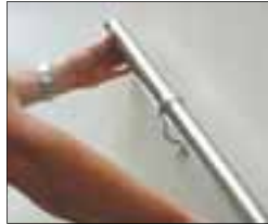
7 Être contenu la main courante dans les support
