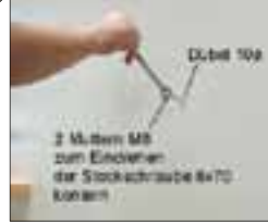
8 Fixer la main courante à des support
