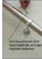
8 Fixer la main courante à des support
